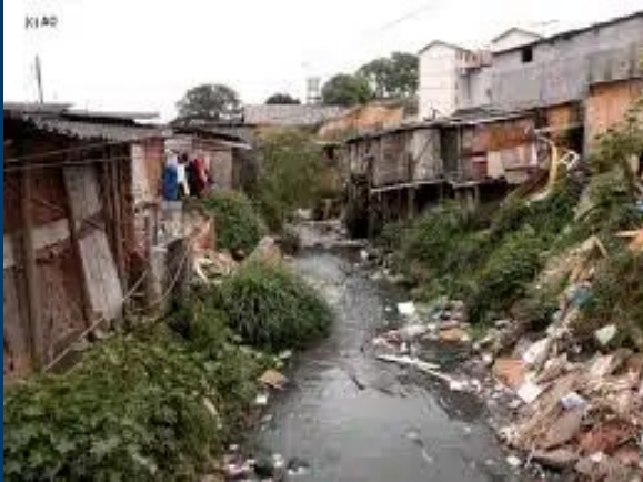
Edificações em APP's
