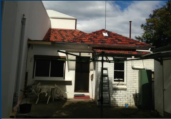
Edificação mal planejada. Sombreamento excessivo
