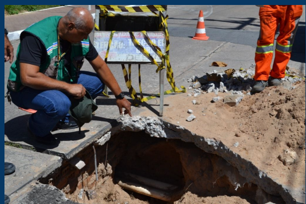
Ligações clandestinas de esgoto
